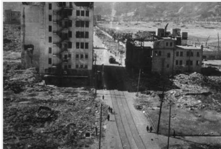
ABBILDUNG 12: GEBÄUDE IN DER RIJO DORI STREET IN DER INNENSTADT HIROSHIMAS WURDEN OFFENSICHTLICH NICHT VON DER DRUCKWELLE GETROFFEN
